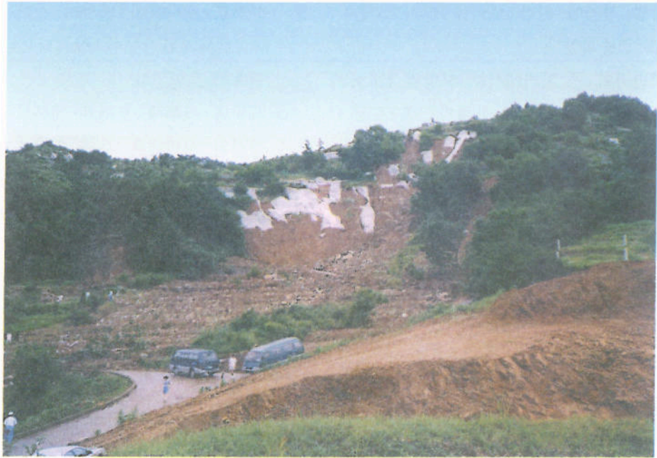
용미리 공원묘역 피해지 (흙막이 공사의 부실로 발생한 편마암지대의 산사태 피해지)
